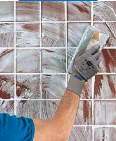
Stesura con spatola gommata
