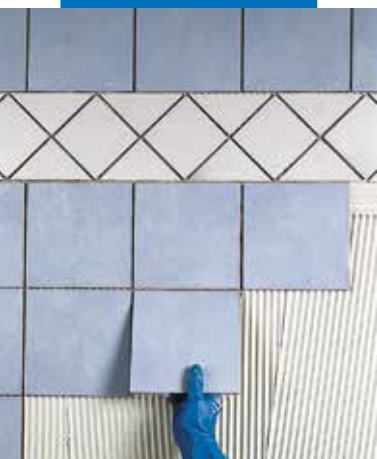
Posa di monocottura a parete di bagno su intonaco
